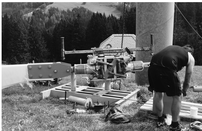
Der Austausch von Baugruppen offenbart das Innenleben des Windkraftwerks.
