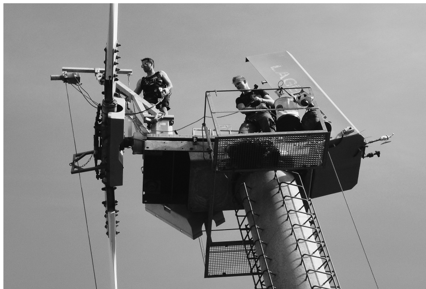
Konzentriertes Arbeiten in luftiger Höhe.
